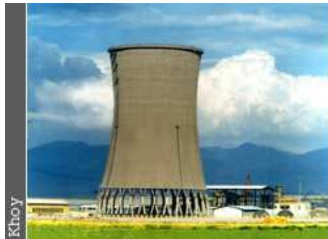
علاوه بر دودکش، کندوی سیلوها، برج خنک کن، پایه های پل های دره ای، پایه های مربوط به دریچه شیر تخلیه درون دریاچه سدهای خاکی، ساخت شفت های سدها و نیروگاه، برج آب گیر سدها، ساخت بنایهای مستطیل شکل مانند ساختمان برج کار سیلوها و هسته ساختمان های بلند نیز با این روش در ایران ساخته شده است. معروف ترین سازه ای که با این روش ساخته شده است برج مخابراتی تهران می باشد که بتن ریزی آن با قالب لغزنده در سال ۱۳۸۳ پایان یافت و در سال ۱۳۸۶ به بهره برداری خواهد رسید.
