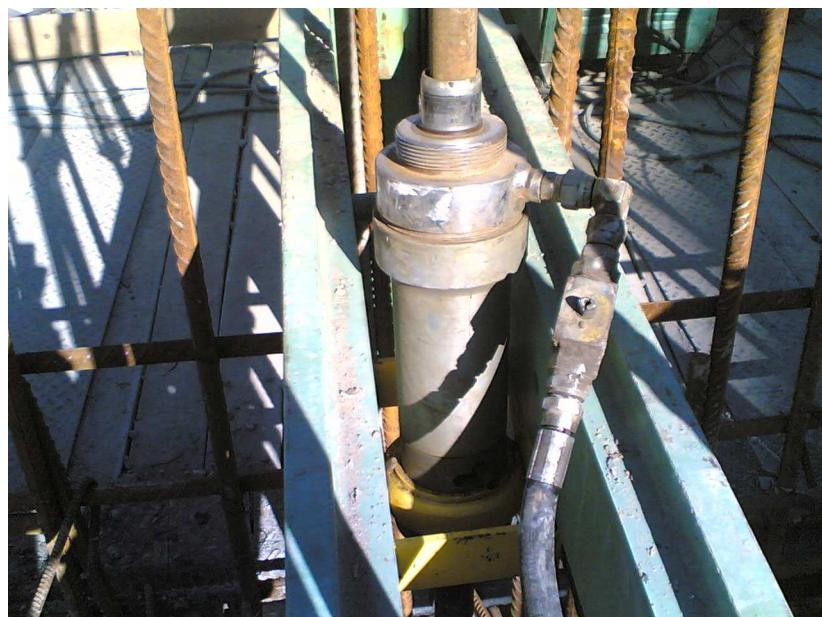
تصویر یک جک واقعی در قالب لغزنده
