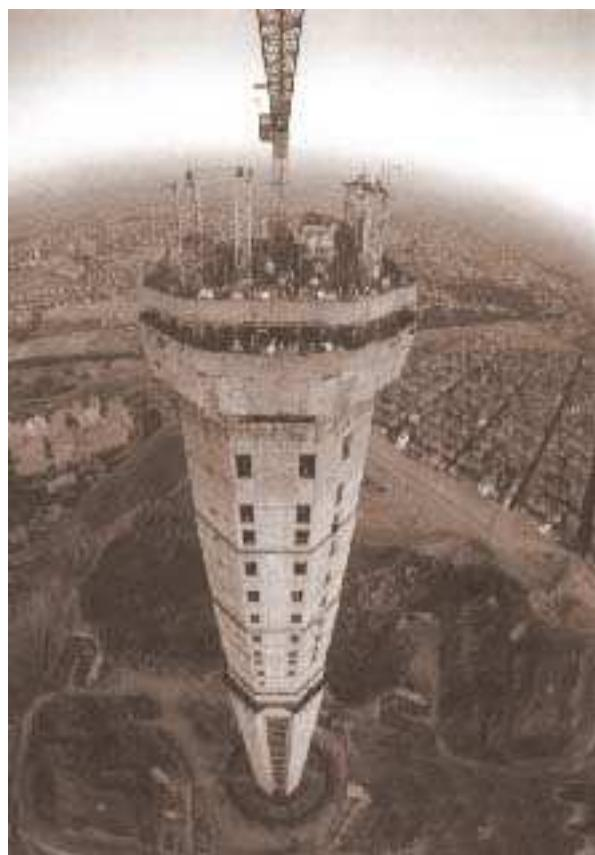
نمای کلی برج تهران و قالب لغزنده روی آن
